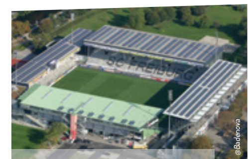
200 Kommanditisten ermöglichen den Bau von einer Anlage mit einer Leistung von 1 MW auf dem Tribürendach des SC Freiburg.
