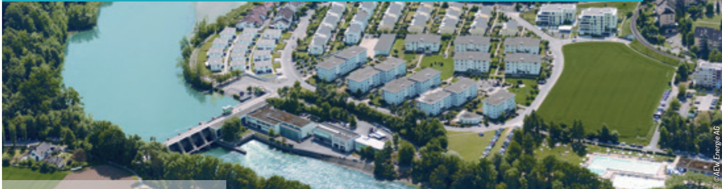
Das Wasserkraftwerk Bremgarten-Zufikon an der Reuss wurde 1975 in Betrieb genommen. Es hat eine installierte Leistung von 20MW.
