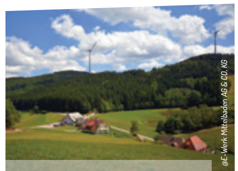
Der Windpark Prechtaler Schanze wurde 2015 in Betrieb genommen. Die sechs Windkraftanlagen haben eine Leistung von 18MW.
