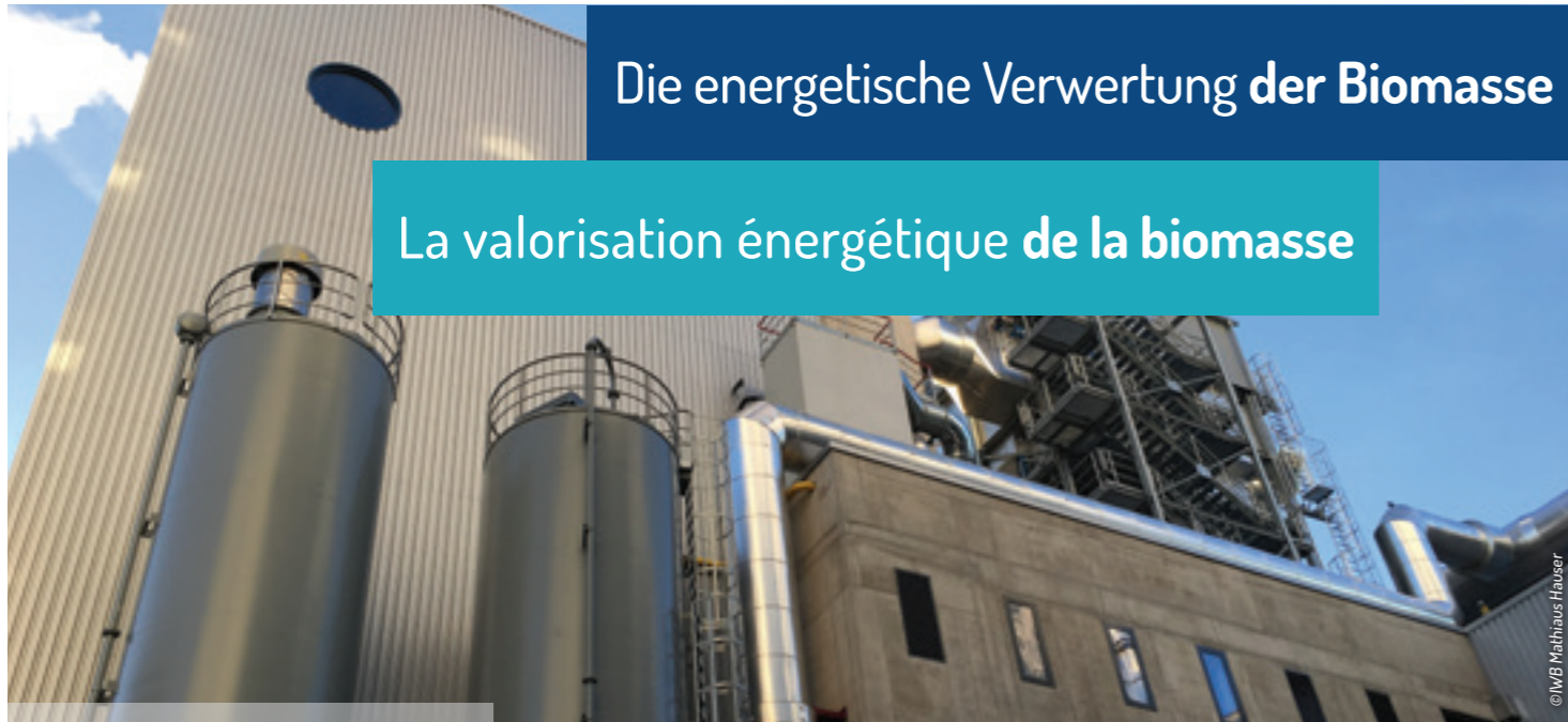
Das Holzkraftwerk II in Basel wurde 2019 in Betrieb genommen, in 2021 produziert es 62,56GWh Wärme sowie 25,36GWh Strom.
