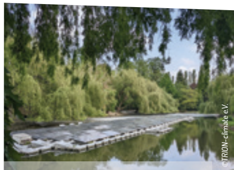
Die im Februar 2018 installierte Anlage in Illkirch-Graffenstaden ermöglicht es die tatsächliche Leistung dieser Art von Anlagen und die Auswirkungen auf die Umwelt zu beurteilen.
