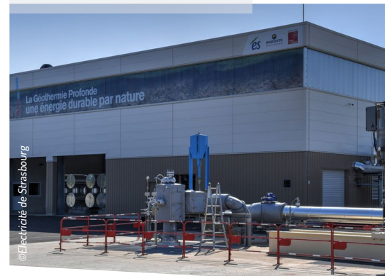
Geothermisches Kraftwerk Rittershoffen. Centrale géothermique de Rittershoffen.
