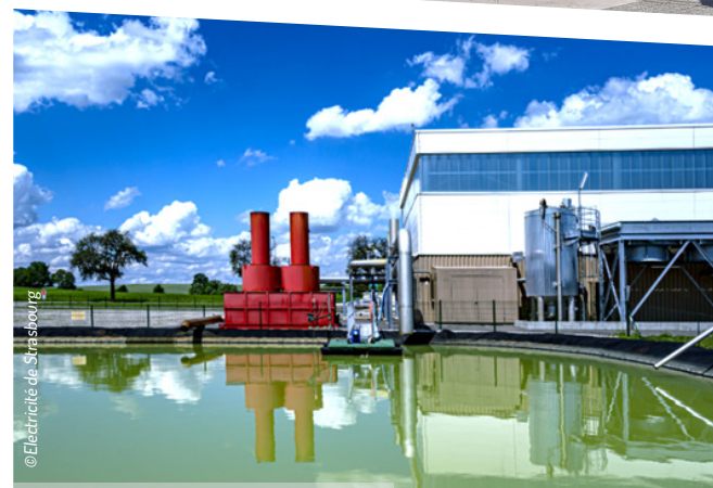
Geothermisches Kraftwerk Rittershoffen. Centrale géothermique de Rittershoffen.
